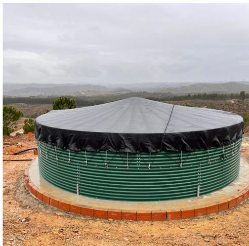
Uma das soluções mais eficazes e com melhor relação custo/benefício é a utilização de depósitos de água em chapa galvanizada e com revestimento interior em tela FPP. Com este tipo de depósito conseguimos uma capacidade de armazenagem de grandes quantidades de água em áreas reduzidas e em locais de difícil acesso, e tudo isto a custo reduzido.
